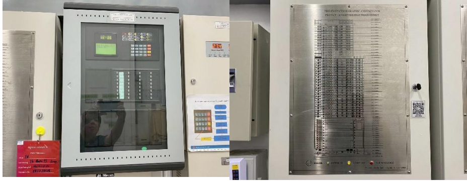
ภาคผนวกที่ 2 ภาพที่ 71 ติดตั้งระบบป้องกันอัคคีภัยเช่น ตู้แจ้งเตือนเหตุเพลิงไหม้
