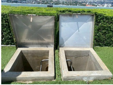
ภาคผนวกที่ 2 ภาพที่ 35 ถึงเก็บน้ำสำรองใต้ดินและและถังน้ำควดฟ้า
