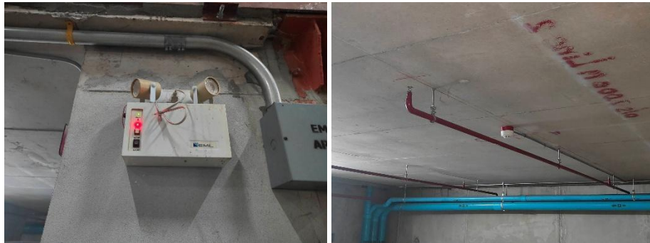
ภาคผนวกที่ 2 ภาพที่ 72 ติดตั้งระบบป้องกันอัคคีภัยในระบบจอดรถยนต์อัตโนมัติ
