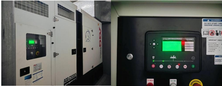
ภาคผนวกที่ 2 ภาพที่ 43 เครื่องกำเนิดไฟฟ้าสำรอง
