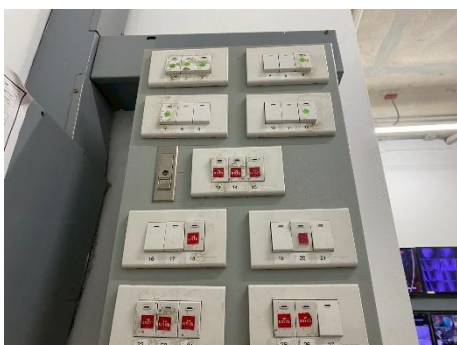
ภาคผนวกที่ 2 ภาพที่ 42 ติดตั้งหลอดLED และมีสวิตช์ควบคุมไฟฟ้าส่องสว่าง
