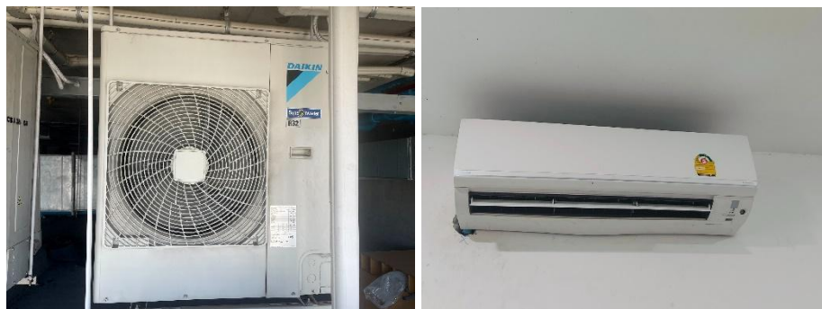
ภาคผนวกที่ 2 ภาพที่ 46 เครื่องปรับอากาศประหยัดไฟเบอร์ 5 และใช้น้ำยา R-32 ที่เป็นมิตรกับสิ่งแวดล้อม
