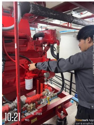
ภาคผนวกที่ 2 ภาพที่ 4 บำรุงรักษาเครื่องสูบน้ำดับเพลิง
