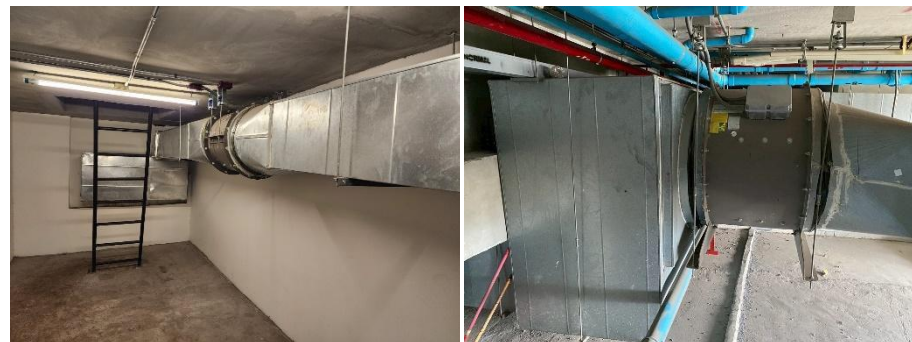
ภาคผนวกที่ 2 ภาพที่ 53 พัดลมระบายอากาศนำอากาศจากห้องพักขยะตามชั้น
