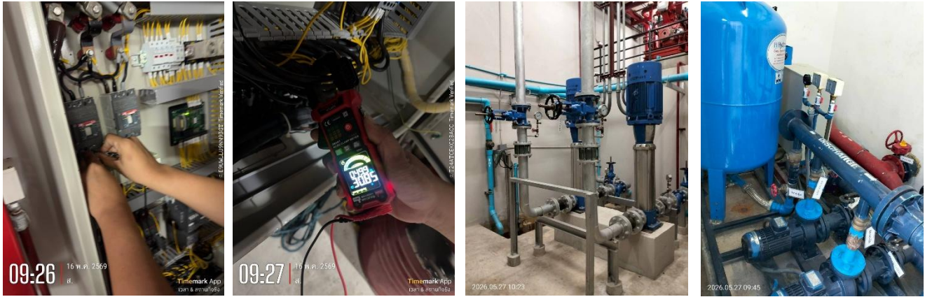
ภาคผนวกที่ 2 ภาพที่ 5 บำรุงรักษาระบบปั้มน้ำดีและปั้มเพิ่มแรงดันน้ำ
