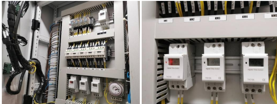
ภาคผนวกที่ 2 ภาพที่ 47 ติดตั้งTimer Digital ควบคุมการเปิด-ปิดไฟแสงสว่าง
