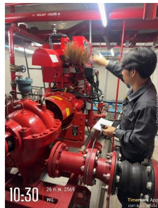
ภาคผนวกที่ 2 ภาพที่ 4 บำรุงรักษาเครื่องสูบน้ำดับเพลิง
